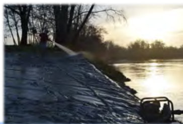
La cale en cours de nettoyage
